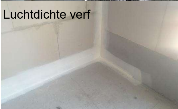
Luchtdichtheid van buitenaf: EP op betonnen muur
